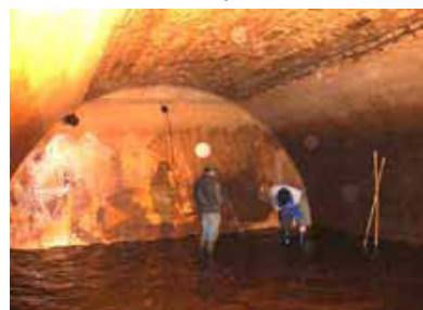
Nettoyage du réservoir
